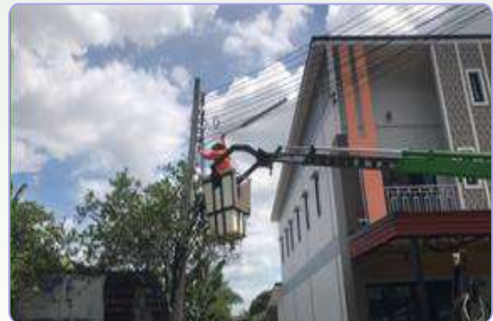
ติดตั้งโคมไฟถนน หมู่ที่ 1
