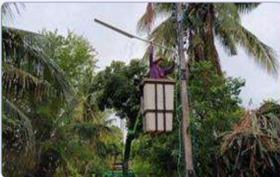
ติดตั้งโคมไฟถนนที่ หมู่ ๑๔
