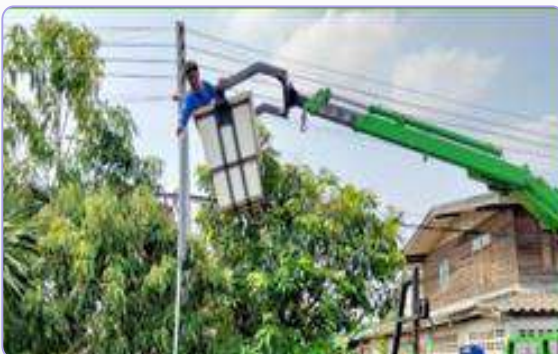
ติดตั้งโคมไฟถนนที่ หมู่ ๒
