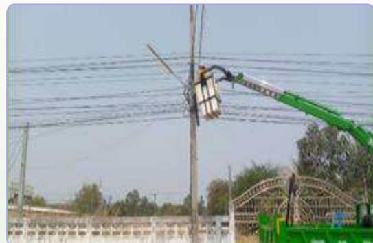
ติดตั้งโคมไฟถนนLED.๑๐๐วัตต์ ที่ถนนโคทอง
